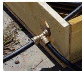
exemple d'un raccord triple
